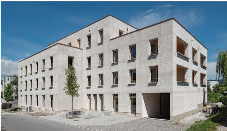
Der Holzsystembau ist mit Hanfbeton gedämmt. Die Fassadenoberfläche ist aus Kalkputz. © Openly, Jens Ellensohn
